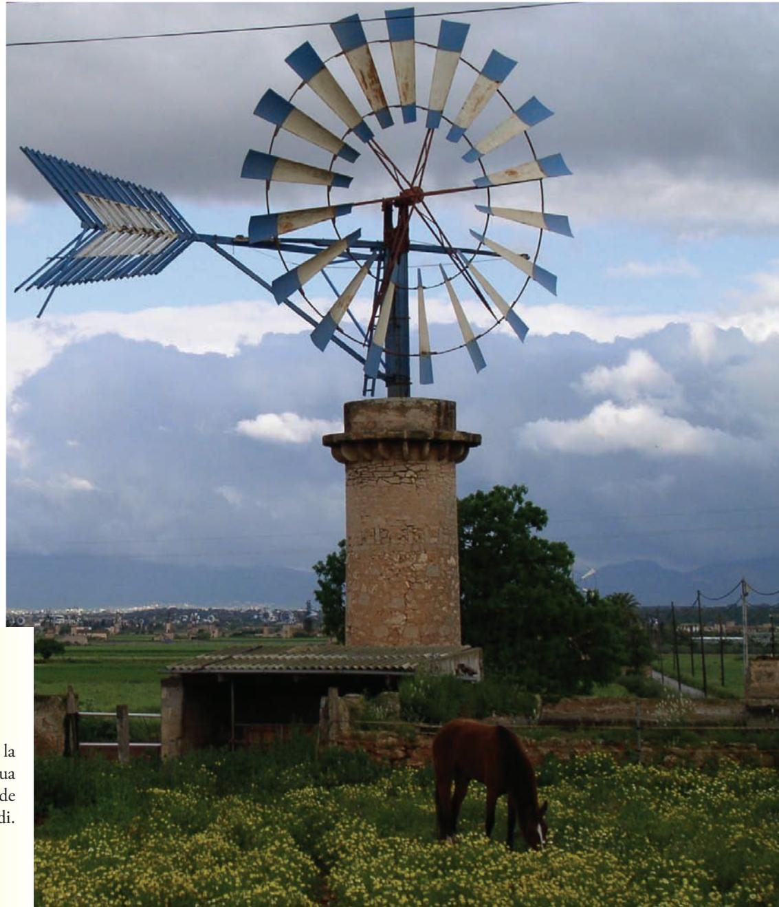
Molino de viento para la extracción de agua subterránea en el Pla de Sant Jordi.
