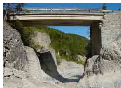
Photo 2.23 : Détecteur de lave torrentielle
