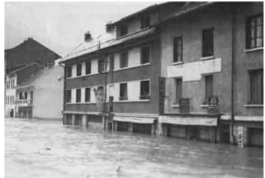
inondation dans les rues de Modane
