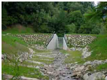
Photo 2.19 : Plage de dépôt - Verdun sur Ariège
