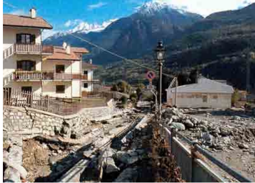
Photo 6.9 : Val d'Aoste 2000, destruction des réseaux
