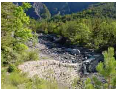
Photo 2.15 : Barrage en maçonnerie – Villeneuve d'Entraunes
