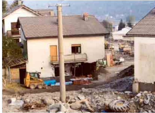
Photo 6.8 : Val d'Aoste 2000, endommagement d'un angle
