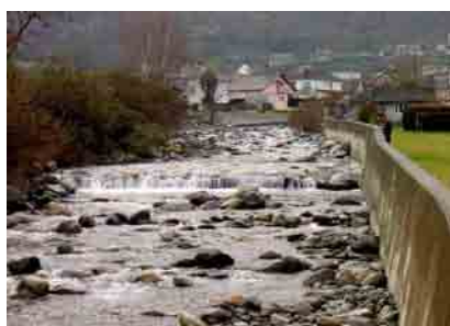
Photo 2.24 : Endiguement d'une rivière torrentielle - Soulom
