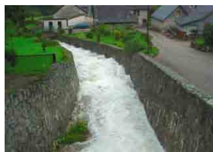
Photo 2.26 : Canalisation d'un torrent - Bielle
