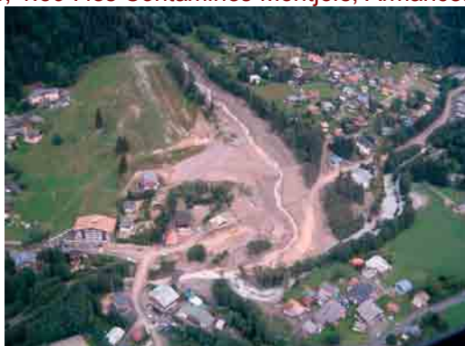
Source : Mairie des Contamines-Montjoie
