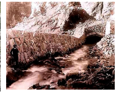
Photo 2.17 : Tunnel de dérivation - Guillestre
