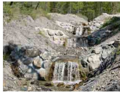
Photo 2.16 : Barrages en enrochements - Embrun
