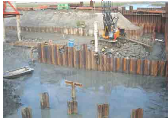
Photo 6.13 : Rideau de palplanches en acier
