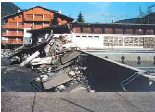
Photo 6.10 : Saint-Lary 1982, dégâts à la piscine
