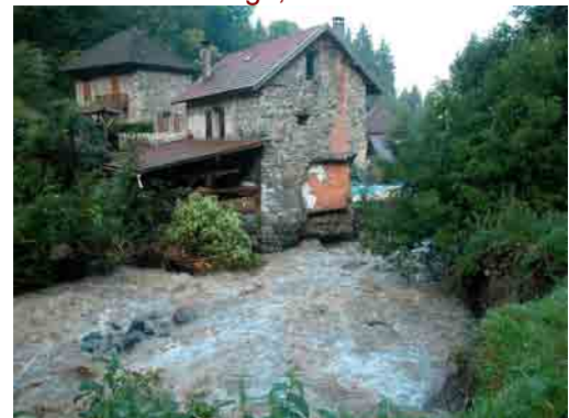
Photos 4.7, 4.8, 4.9 : Vulnérabilité des angles des bâtiments en maçonnerie Voiron, 1897
