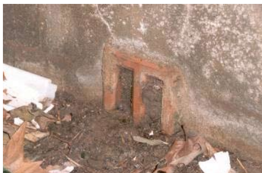
Endommagement après pénétration d'eau à travers une entrée d'air. (CSTB)
