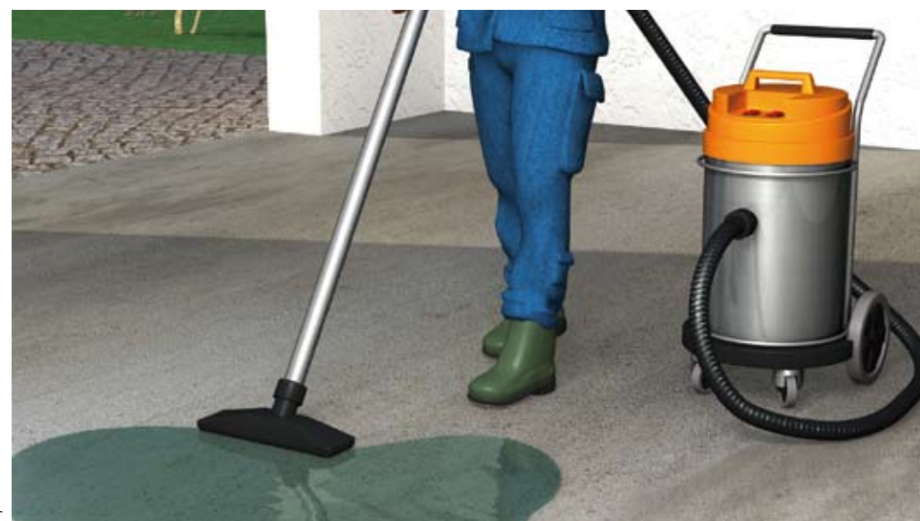
Elimination des eaux résiduelles au RDC.
