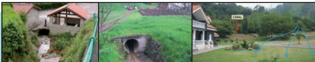
Figura 193. Criterios empleados en la zonificación de la peligrosidad torrencial. Izquierda y centro, desenchajamientos de cauces torrenciales agravados por drenajes soterrados con sección insuficiente. Derecha, morfología del depósito torrencial.
