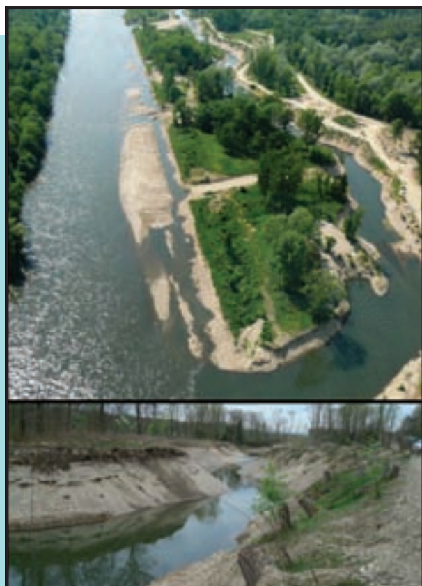
Figura 88. Proyecto de recuperación de antiguos canales secundarios en Gosdorf (Austria). Para minimizar el encajamiento, se vierte el material extraído al cauce (Hornich and Baumann, 2008).
