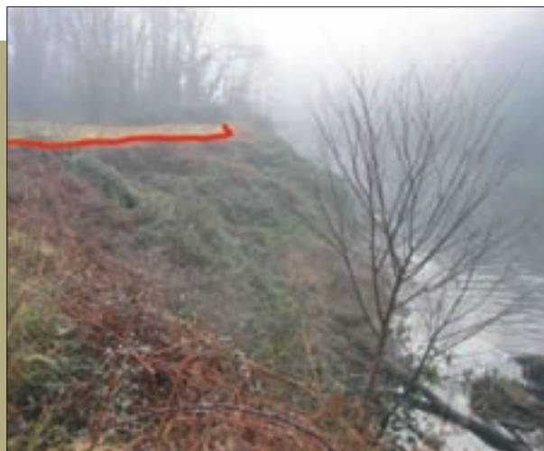
Figura 121. La línea señala la coronación del talud de la orilla, representativa del DPHP.
