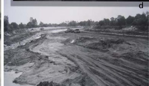
(a) Plans (site D4), (b) photos aériennes et (c, d) terrestres des travaux de rescindement de la Loue en amont du pont d'Ounans (années 60).
