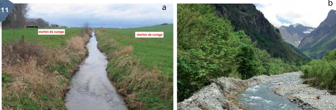
Merlons de curages pérennes (a) (faible dynamique) et non pérennes (b) (forte puissance : merlons repris à la première crue).
