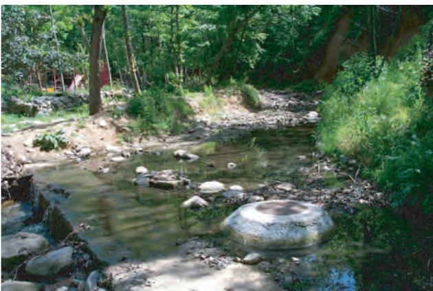
4i) estructura sólida (tapa del colector) en el lecho del río
