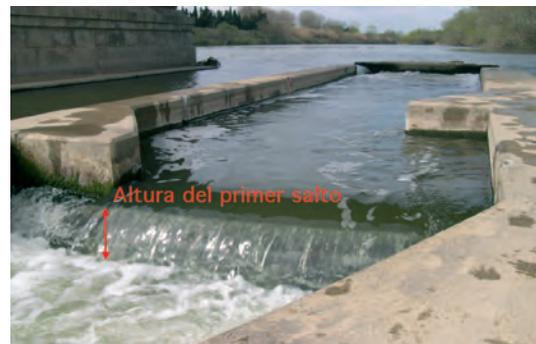
**Imagen 5.** Altura del primer salto en la entrada de una escala de peces.
