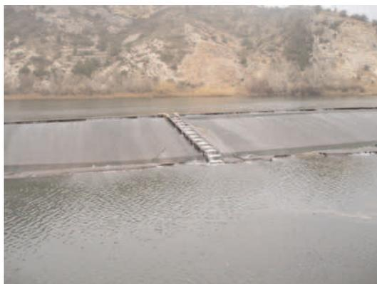
**Imagen 6.** Escala de peces en Xerta, Ebro. La localización es inadecuada porque no crea una corriente de atracción para los peces.
