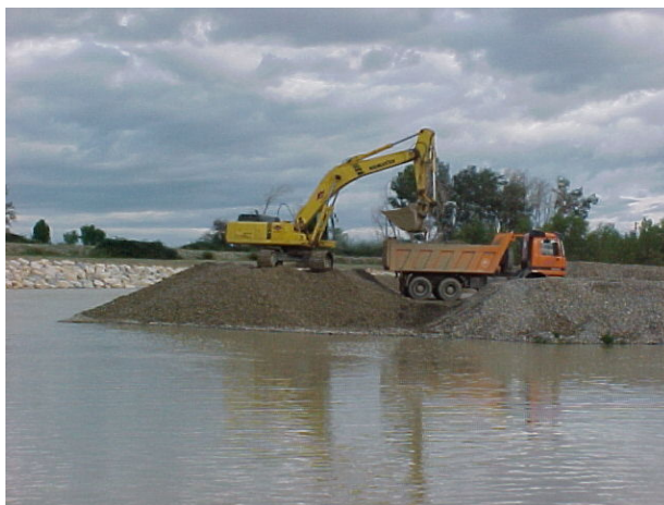
Foto 21: Dragado del río Aragón en Sotocontiendas (Marcilla)
