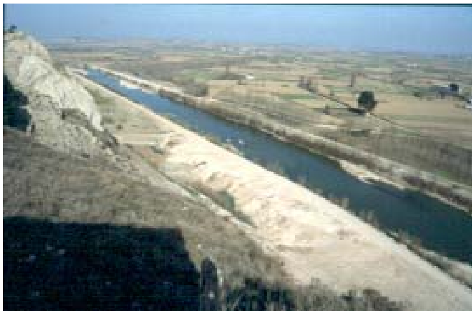
Foto 6: Bajo Arga canalizado (A.Ollero)
