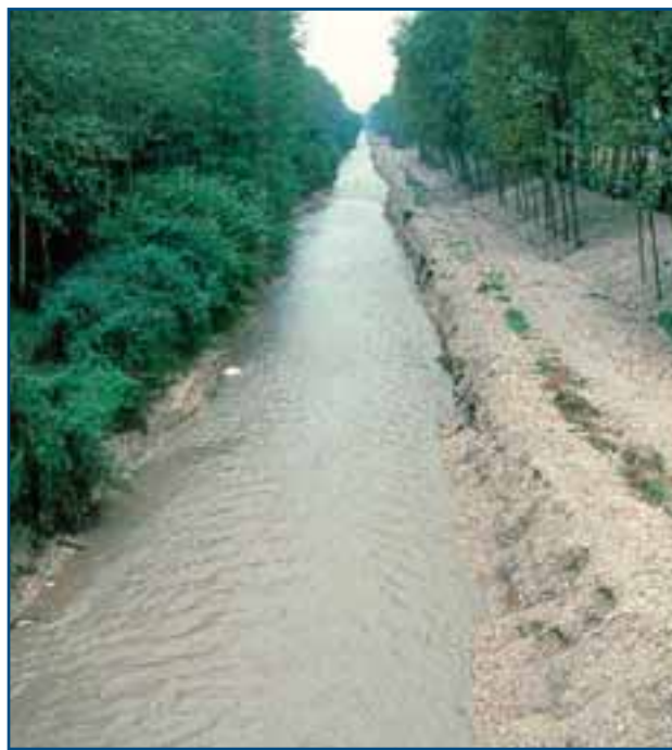
Figure 20 : Exemple de cours d'eau ayant subi des interventions multiples : surcalibrage, rescindement, endiguement, curage, etc. 🌊
