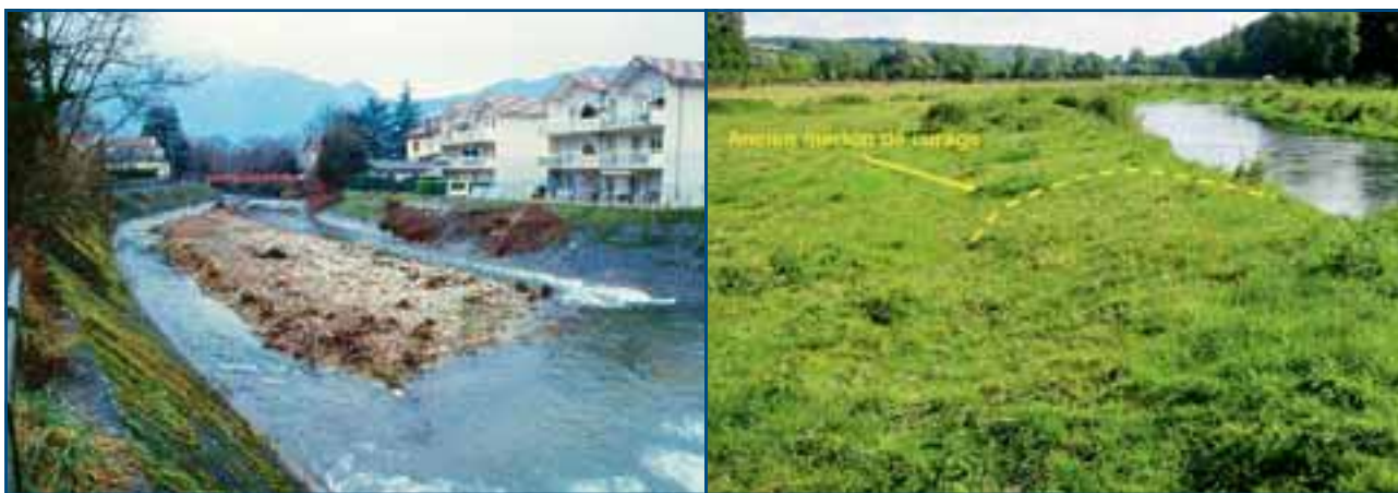
Figure 31 : A gauche, endiguement en béton sur les deux berges en zone urbanisée. A droite : ancien merlon de curage en bordure de la Scie (76). ≈
