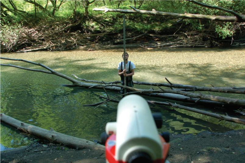
*Mediciones de seguimiento con nivel topográfico en el seguimiento del derribo de la presa de Inturia (río Leitzaran, Andoian, Gipuzkoa). Foto: Askoa Ibisate.*
