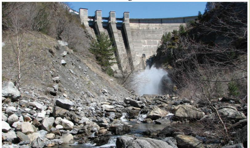
*Acorazamiento de bloques al pie de la presa de Paso Nuevo (río Ésera).
