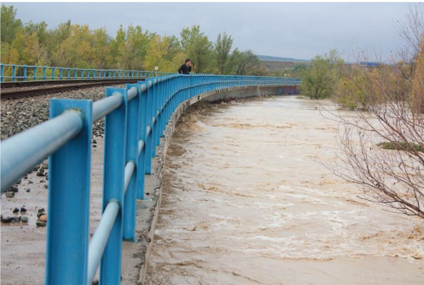
*Puente horizontal mal dimensionado de acceso ferroviario a la papelera de Montañana (río Gállego, Zaragoza), con efecto presa en la crecida de octubre de 2012. Foto: Pilar Cabrero.*
