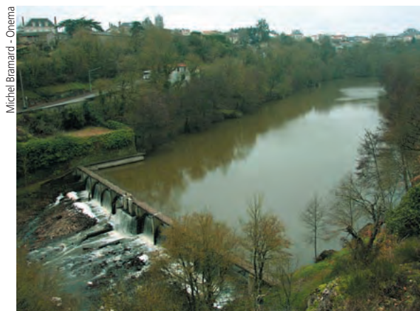
Homogénéisation des faciès d'écoulement dans la retenue d'un seuil.
