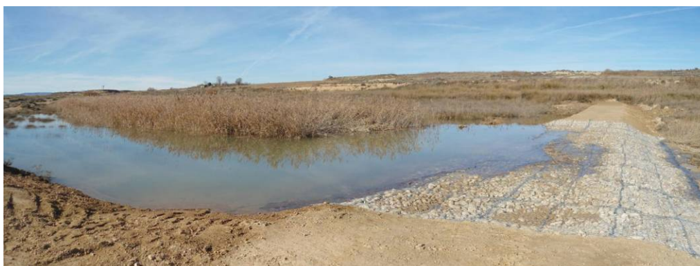
Figura 2.2 Aliviadero y mota construidos en Lalueza con su nueva zona húmeda asociada
