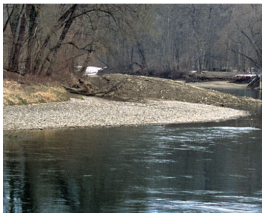
Figure 7.29 : Déversement de graviers au bord de la Reuss à Foort, Eggenwil, AG. Photo de gauche : dépôt de graviers à l'arrière d'un banc de graviers naturel. Photo de droite : le banc de gravier déversé a été entraîné lors de la crue d'août 2005. (Photos : Oekovision GmbH, 8967 Widen.)
