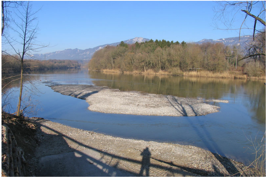
Figure 7.28 : Banc de gravier déversé dans l'Aar près de Deitingen, SO, 2005 (Photo : U. Schälchli, Schälchli, Abegg + Hunzinger).
