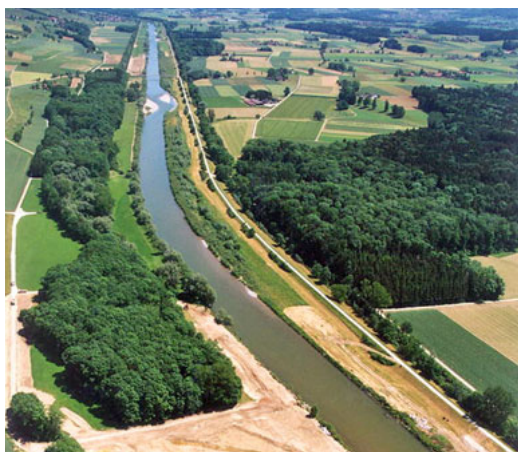
Figure 7.6 : Elargissement de petite dimension dans le Liechtensteiner Binnenkanal à Ruggeli, 2005 (Photo : A. Peter, Eawag).
