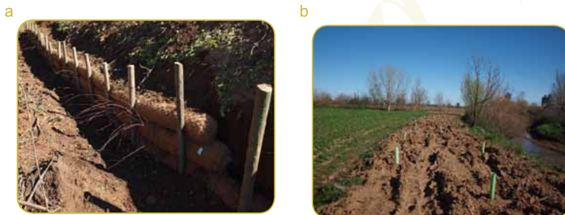
Figura 9. a) Colocación de biorollo con estacas vivas de sauce blanco, b) Buffer de plantación de arbustos espinosos y especies arbóreas. Fotos: Jerónimo Carrascal.
