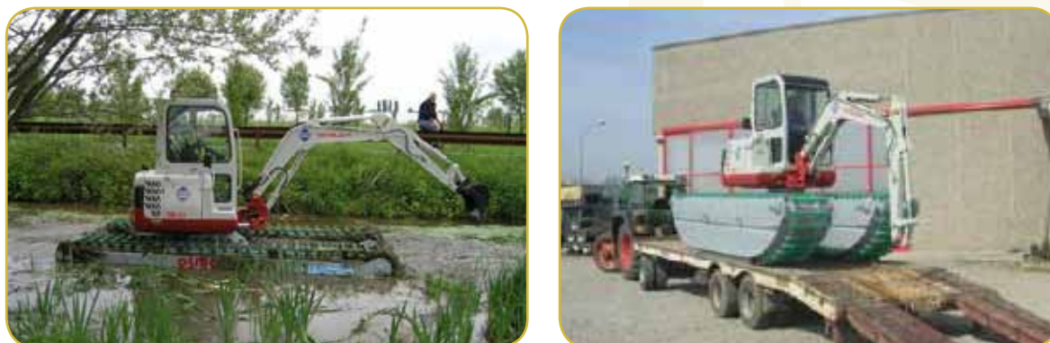
Figura 4. a) Miniexcavadora anfibia trabajando en un río. Foto: Osma snc. b) Detalle de la colocación de pontones adicionales para la flotación en excavadora de gran tonelaje. Foto: Remu Ltd. c) Excavadora trabajando en aguas profundas estabilizada con la ayuda de las patas de anclaje. Foto: Remu Ltd.
