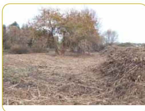
Figura 6. Rebaja de la mota para conectar parcialmente el tramo I con el tramo II. Fotos: Jerónimo Carrascal.
