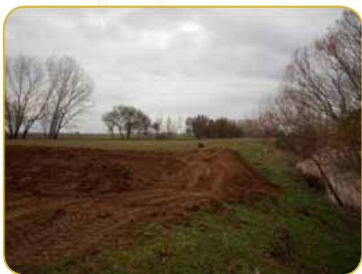
Figura 6. Rebaja de la mota para conectar parcialmente el tramo I con el tramo II. Fotos: Jerónimo Carrascal.
