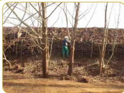
Figura 7. a) Talud antes de aplicar la empalizada, b) Empalizada trenzada de sauce en tramo III. Fotos: Jerónimo Carrascal.
