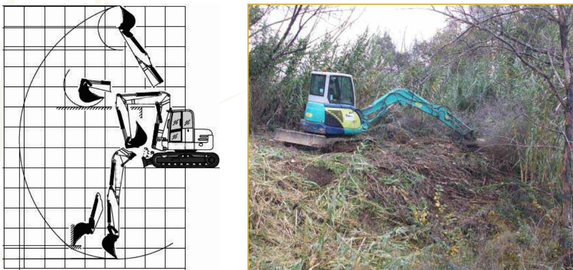
Figura 2. a) Representación de una excavadora de cadenas con pala dozer frontal. b) Miniexcavadora eliminando cañas ( Arundo donax ) con un triturador de cadenas. Foto: Jerónimo Carrascal.
