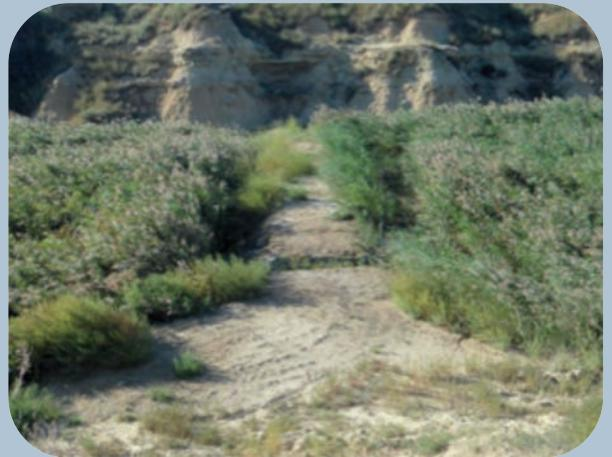
**Fig. 2.8.** Sección del humedal *in stream* Lalueza en Monegros (Huesca) del Proyecto CREAMAgua. Se aprecia (izda.) uno de los diques recién construidos para ampliar su anchura y aumentar el tiempo de residencia del agua y (dcha.) al cabo de 2 años.
