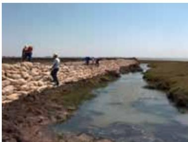
Pose manuelle d'un brise-lames dans le marais salant du Consulado
