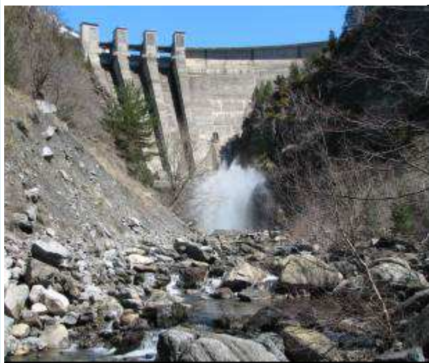
Acorazamiento en bloques al pie del embalse de Paso Nuevo (río Ésera). Foto: Daniel Mora.
