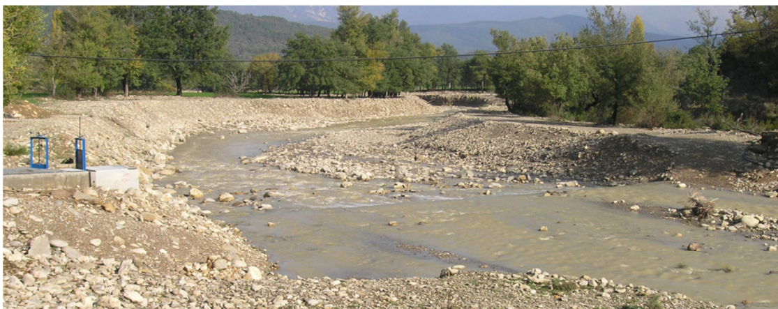
Efectos en el río Sieste (Sobrarbe, Huesca) de una actuación de emergencia tras una crecida en 2001.
