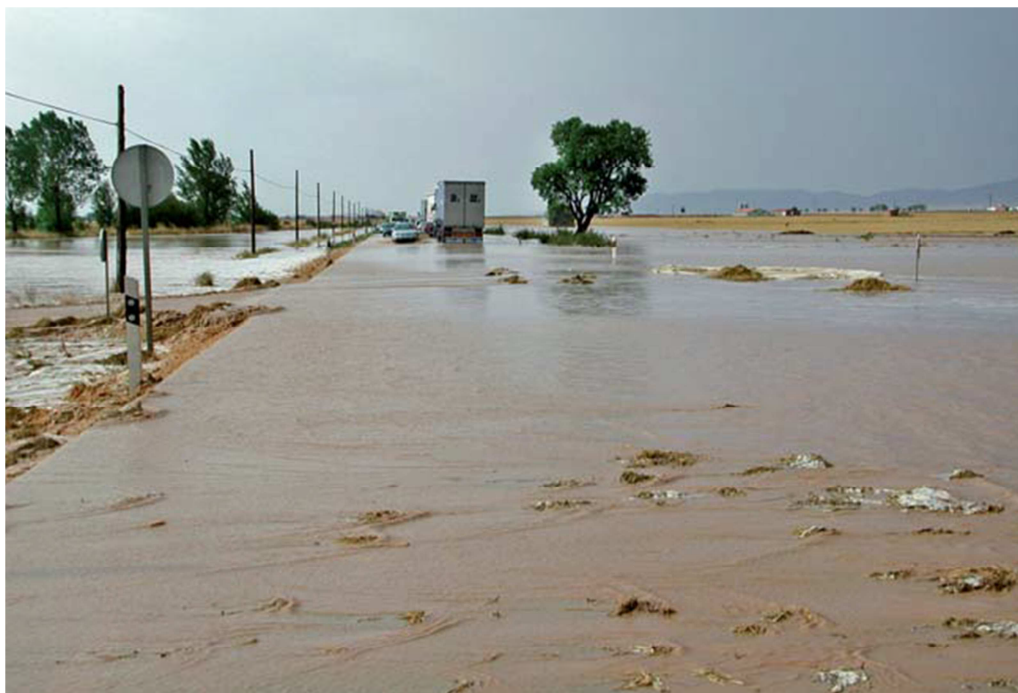
Inundación de la N-234 en agosto de 2001 en Villarquemade (Teruel). Foto de F. Montero.
