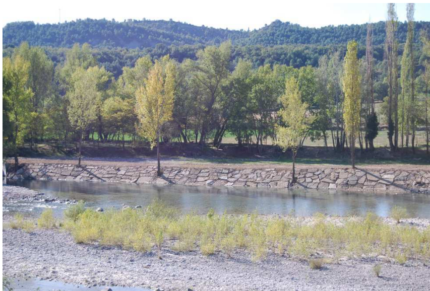
Escollera en el río Ara entre Boltaña y Aínsa. Los árboles insertados sufren muchos problemas para sobrevivir.
