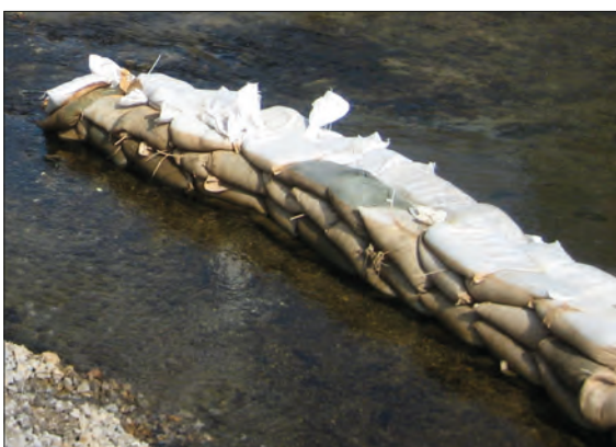
Imagen 24. Base del dique colocado a tizón
