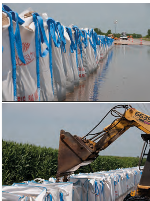
Imagen 31. Construcción de diques con sacos de escombros
