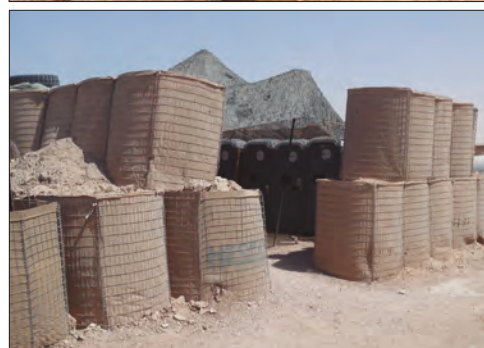
Imagen 27. Construcción de dique con gaviones modulares
