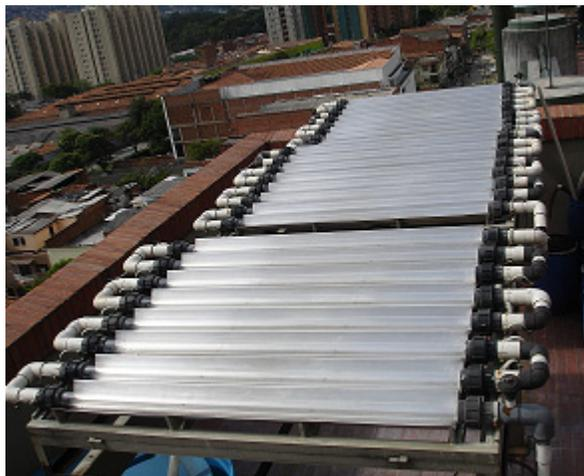
Figura 4. Colectores solares para fotocatalisis.
