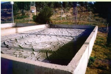
**Figura 39.- Eras de secado de lodos.**
