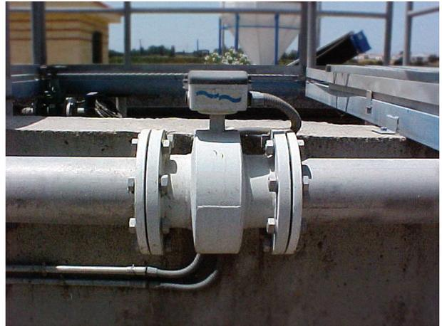
**Figura 21.- Caudalímetro electromagnético.**
