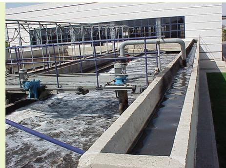
**Figura 19.-** Desarenador-desengrasador aireado.
