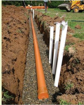
**Figura 45.- Sistemas de aplicación subsuperficial al terreno: Zanja Filtrante.
