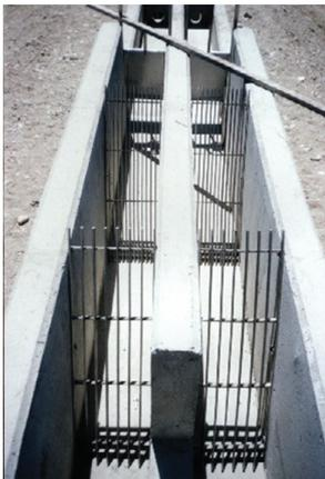
**Figura 11.- Desbaste de gruesos seguido de desbaste de finos, empleando rejas rectas de limpieza manual.**
