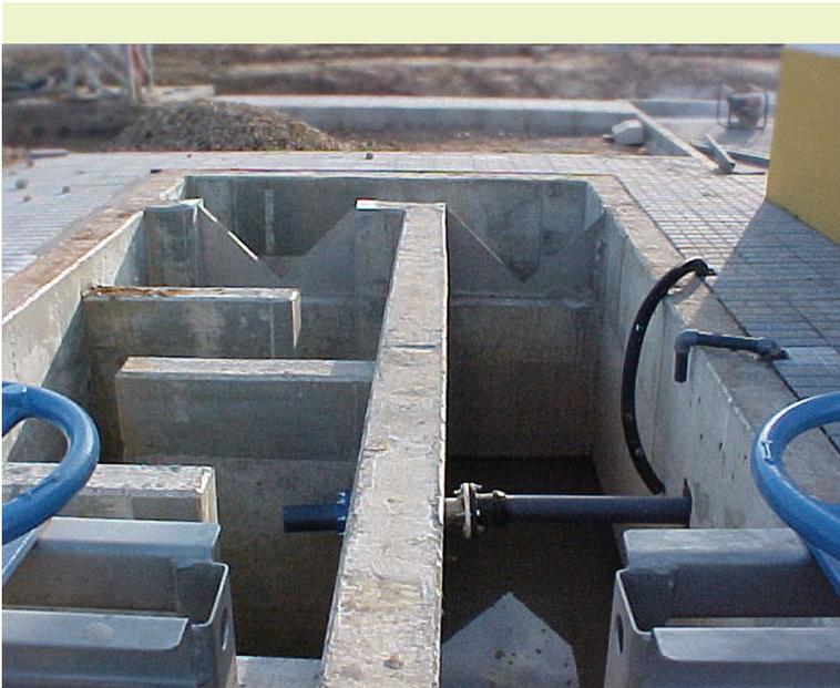
**Figura 22.- Medición de caudal en vertedero triangular.**
