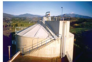
**Figura 34.- Digestor anaerobio para la estabilización de los lodos.**
