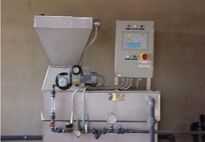
**Figura 36.-** Equipo para el acondicionamiento químico de los lodos antes de su deshidratación.
