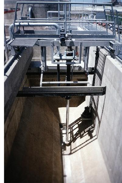
**Figura 18.-** Detalle interno de un desarenador-desengrasador aireado.
