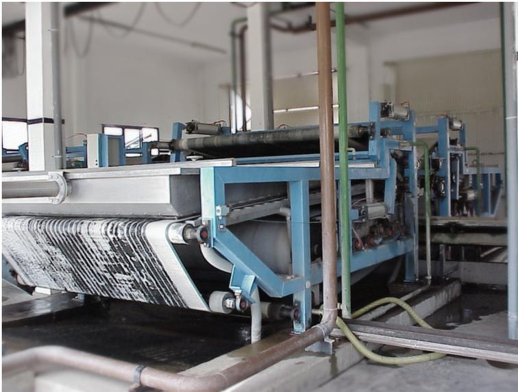
**Figura 38.- Deshidratación de lodos mediante filtro banda.**
