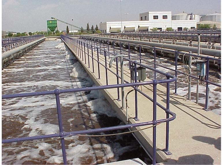
**Figura 26.-** Cuba biológica con aireación por difusores.
