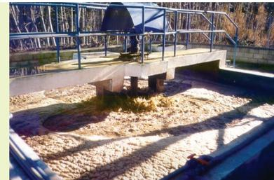
Figura 25.- Cuba biológica con aireador mecánico superficial.
