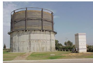
**Figura 35.- Gasómetro para el almacenamiento del biogás generado en la etapa de estabilización anaerobia de los lodos.**
