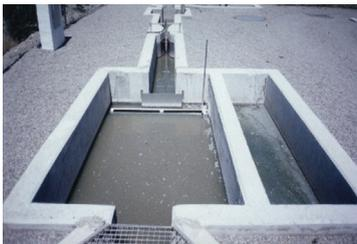
**Figura 17.-** Desengrasador estático, con tubería acanalada giratoria para la retirada de los flotantes.
