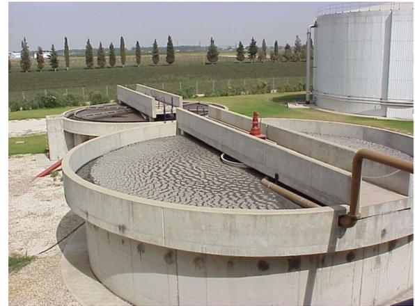
**Figura 33.- Espesadores de lodos, por gravedad y por flotación.**
