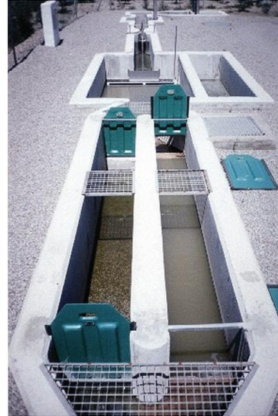
**Figura 16.- Desarenador de flujo variable de doble canal.**
