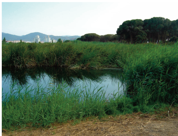
Figura 62.- Humedal Artificial de Flujo Superficial de Can Cabanyes. (Granollers, Barcelona).
