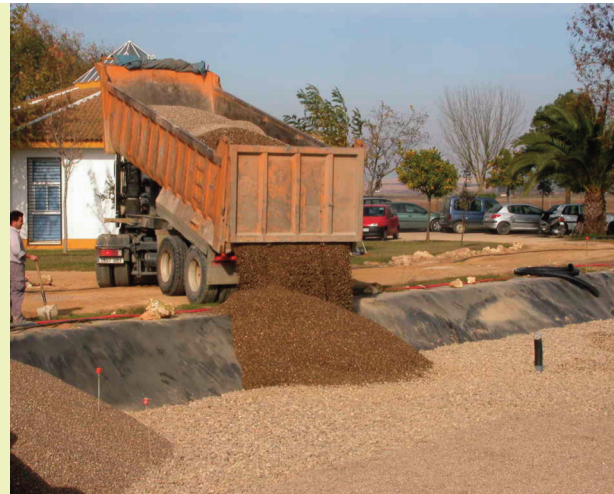
Figura 37.- Descarga directa de áridos en el interior de un Humedal Artificial.
