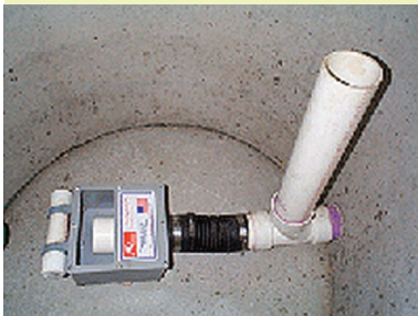
Figura 44.- Sifón de descarga controlada (Fuente: Rissi Plastics LLC).
