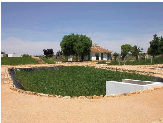
Figura 68.- Humedal Artificial de Flujo Subsuperficial Horizontal en la PECC.
