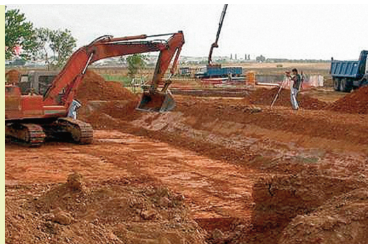
Figura 19.- Perfilado de los taludes del confinamiento de un Humedal Artificial.
