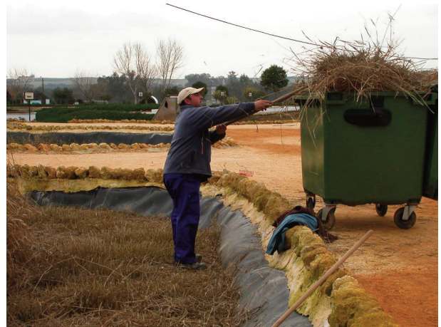
Figura 54.- Evacuación de la biomasa seca tras la siega de un humedal.
