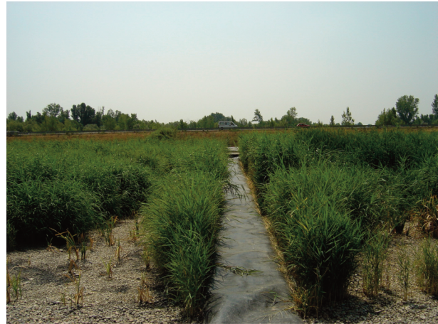
Figura 60.- EDAR de Corbins, 2.000 h.e. (Lérida).
