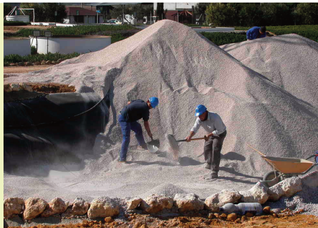
Figura 39.- Distribución manual de áridos en un Humedal Artificial .
