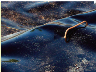
Figura 23.- Sujeción de la lámina plástica mediante grapa metálica.
