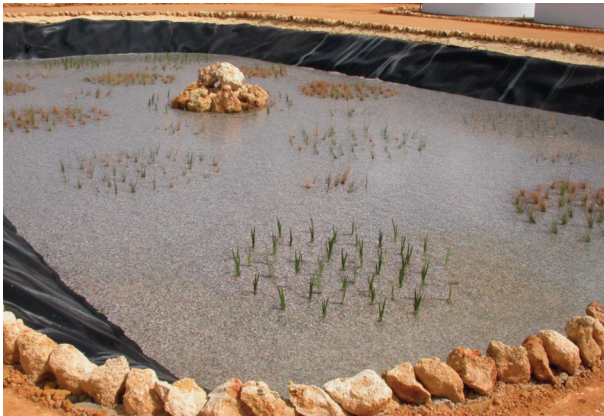
Figura 45.- Aspecto de un Humedal de Flujo Superficial recién plantado.
