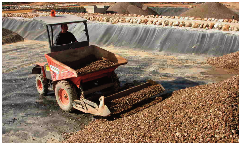
Figura 40.- Distribución mecánica de los áridos en un HAFSs Horizontal .
