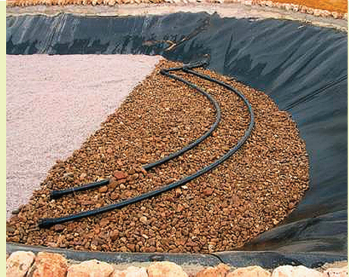
Figura 41.- Tuberías de reparto en un HAFSs Horizontal.
