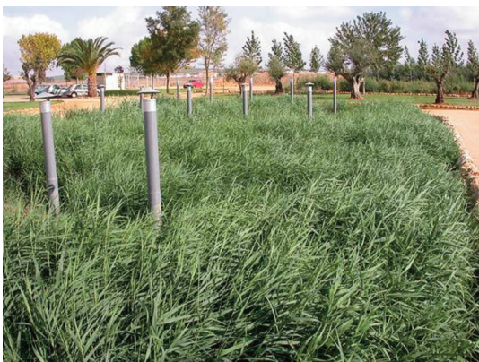
Figura 69.- Humedal Artificial de Flujo Subsuperficial Vertical en la PECC.
