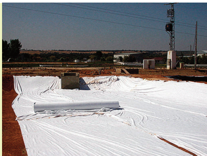
Figura 20.- Colocación de una lámina de geotextil en un Humedal Artificial.
