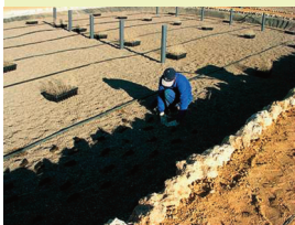
Figura 48.- Distribución de las bandejas con plantas de vivero para lograr una plantación uniforme del humedal.
