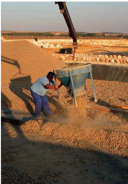
Figura 38.- Descarga de áridos mediante cubilete en un Humedal Artificial .
