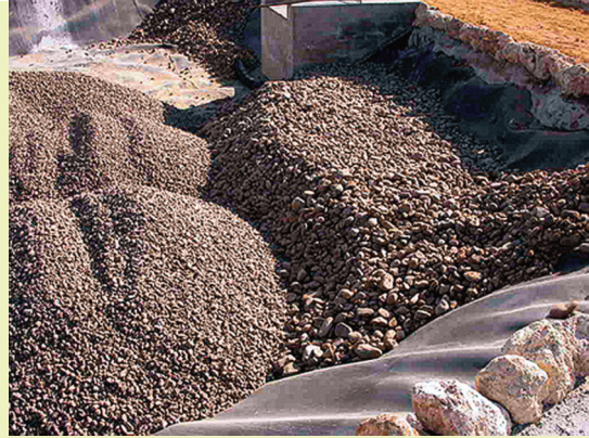
Figura 27.- Recubrimiento de los drenes de evacuación con una capa de bolos de 50-100 mm.
