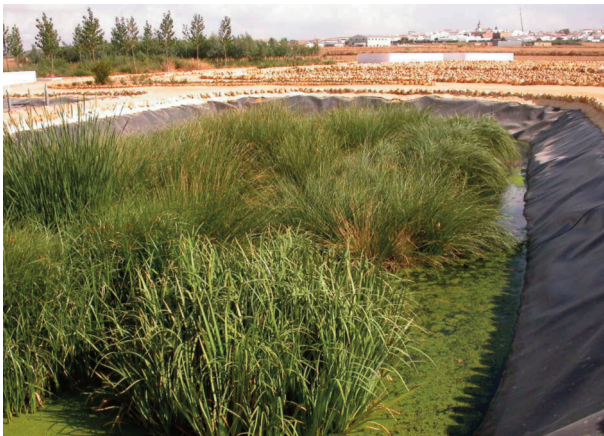
Figura 46.- Aspecto del Humedal de Flujo Superficial al año de su plantación.
