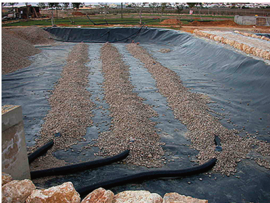
Figura 31.- Las tuberías de drenaje se van cubriendo con una capa de grava de 25-40 mm.
