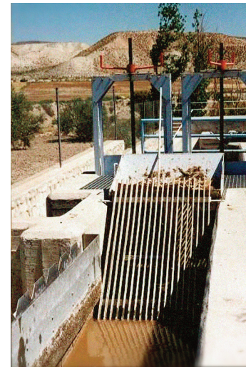
Figura 4.- Esquema y fotografía de una reja de desbaste de limpieza manual.
