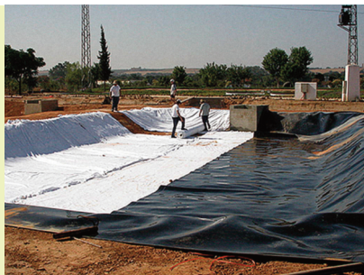
Figura 21.- Colocación de una lámina plástica para impermeabilizar el confinamiento.
