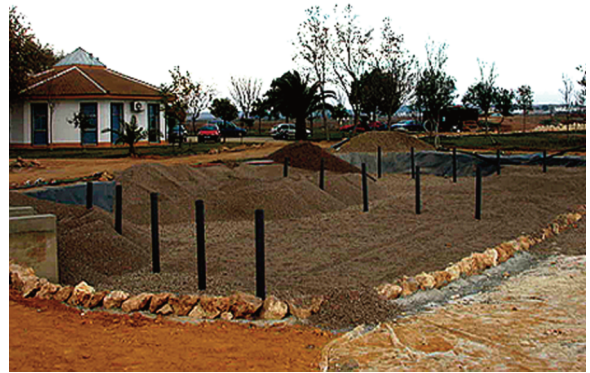
Figura 34.- Colocación de las chimeneas de ventilación en un HAFSs Vertical.
