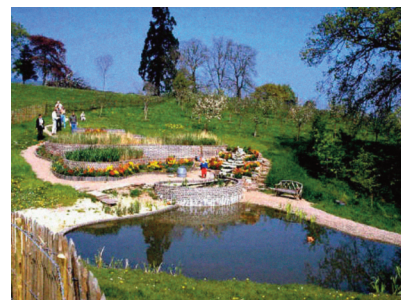
Figura 10.- Lagunaje en cola de una instalación de Humedales Artificiales . (Oaklands Park, Reino Unido).
