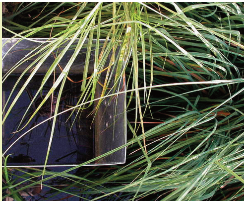
Figura 24.- Chapa deflectora en la salida de un Humedal de Flujo Superficial.
