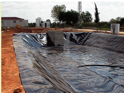
Figura 22.- Aspecto de un humedal tras finalizar la etapa de impermeabilización.
