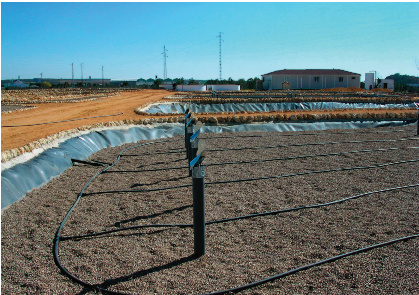
Figura 35.- Detalle de las chimeneas de ventilación en un HAFSs Vertical .
