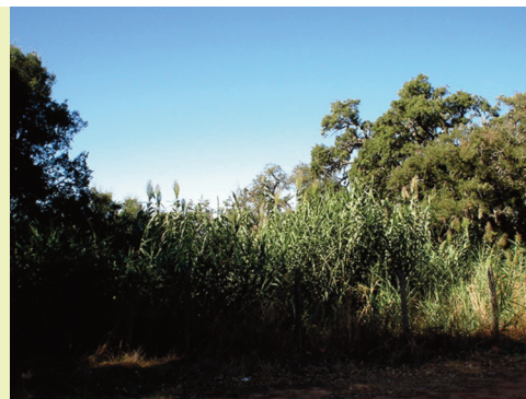
Figura 66.- EDAR del Albergue Juvenil de Cortes de la Frontera (Málaga).
