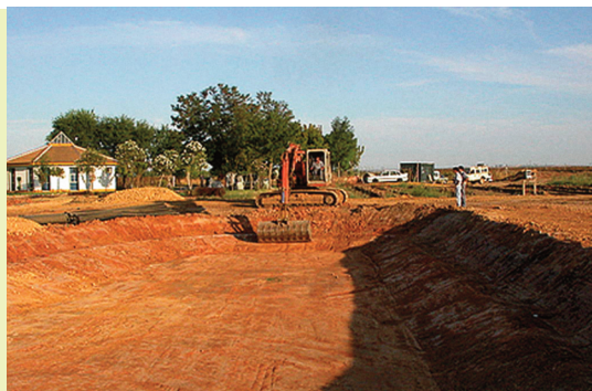
Figura 18.- Excavación del confinamiento de un Humedal Artificial.
