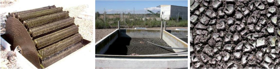
**Figura 48.- Contactor Biológico Rotativo, *Filtro de Turba* en sustitución de la etapa de Decantación Secundaria y aspecto de los lodos secos. Planta Experimental de Carrión de los Céspedes.**
