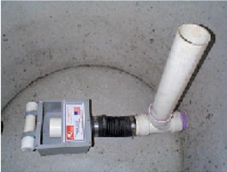
**Figura 45.- Sifón de descarga controlada (Rissi Plastics LLC),**
