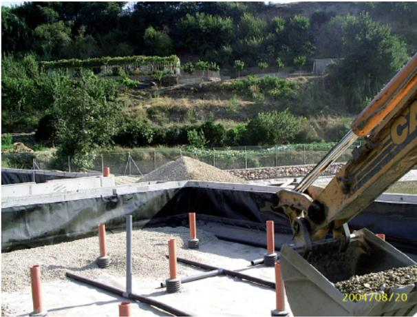
**Figura 29.- Colocación de la primera capa de áridos en la que se embuten las tuberías de drenaje.**
