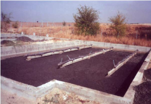
Figura 34.- Sistema de reparto con salidas giratorias.
