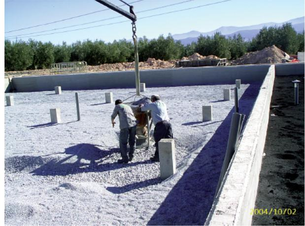
**Figura 30.- Colocación de la última capa de áridos, sobre la que se dispone la capa de turba.**
