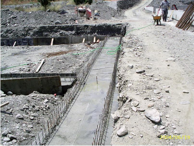
Figura 22.- Construcción en hormigón de los muros verticales del confinamiento de una instalación de *Filtros de Turba*.
