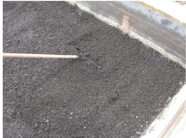
Figura 42.- Escarificado de la superficie del filtro.
