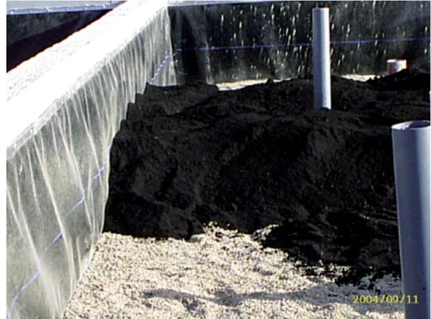
**Figura 32.- Colocación de la capa de turba.**
