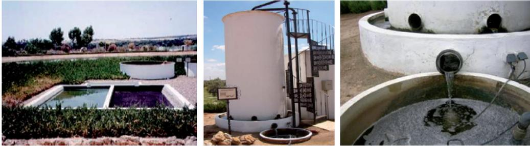
Figura 49. *Filtros de Turba*, Lecho Bacteriano y detalle del efluente a la salida del Lecho Bacteriano. Planta Experimental de Carrión de los Céspedes.
