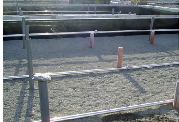
Figura 35.- Tuberías para el reparto homogéneo de las aguas a tratar sobre la turba.
