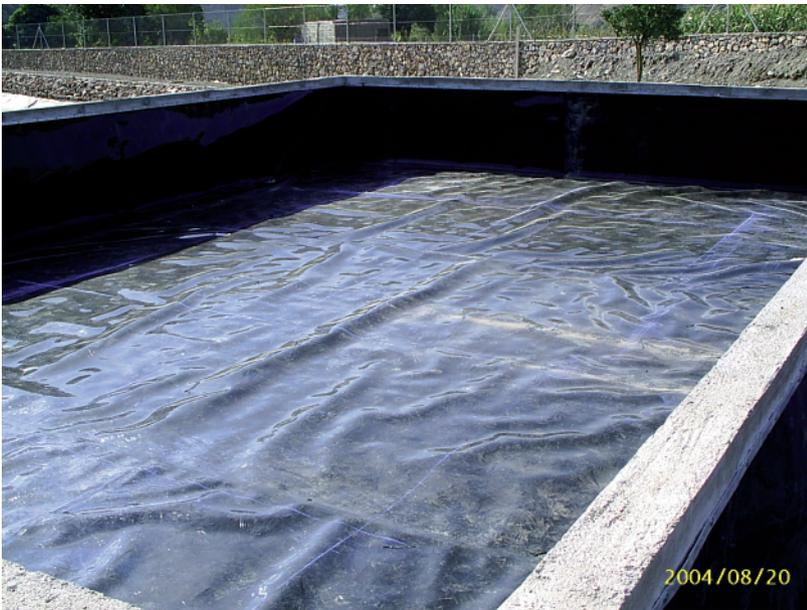
Figura 25.- *Filtros de Turba* con la solera impermeabilizada con lámina plástica de PEAD.
