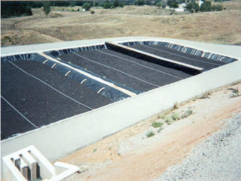
Figura 23.- *Filtros de Turba* contruidos por excavación en el terreno, impermeabilizados con lámina plástica.
