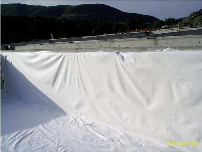
Figura 24.- Colocación de una lámina de geotextil como paso previo a la impermeabilización del vaso de los *Filtros de Turba* con lámina plástica.
