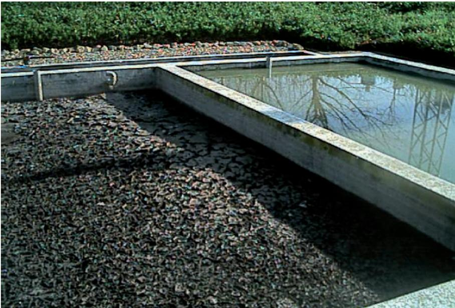
Figura 17.- *Filtros de Turba* en operación y en fase de secado de la costra superficial.
