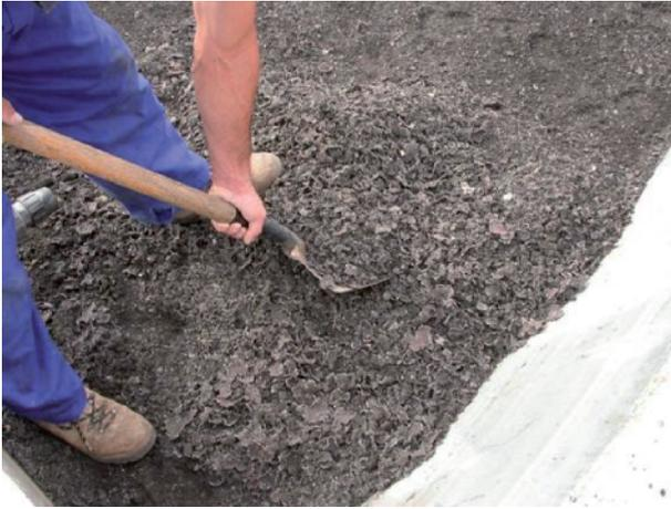
Figura 39.- Extracción de la costra fuera de los filtros.
