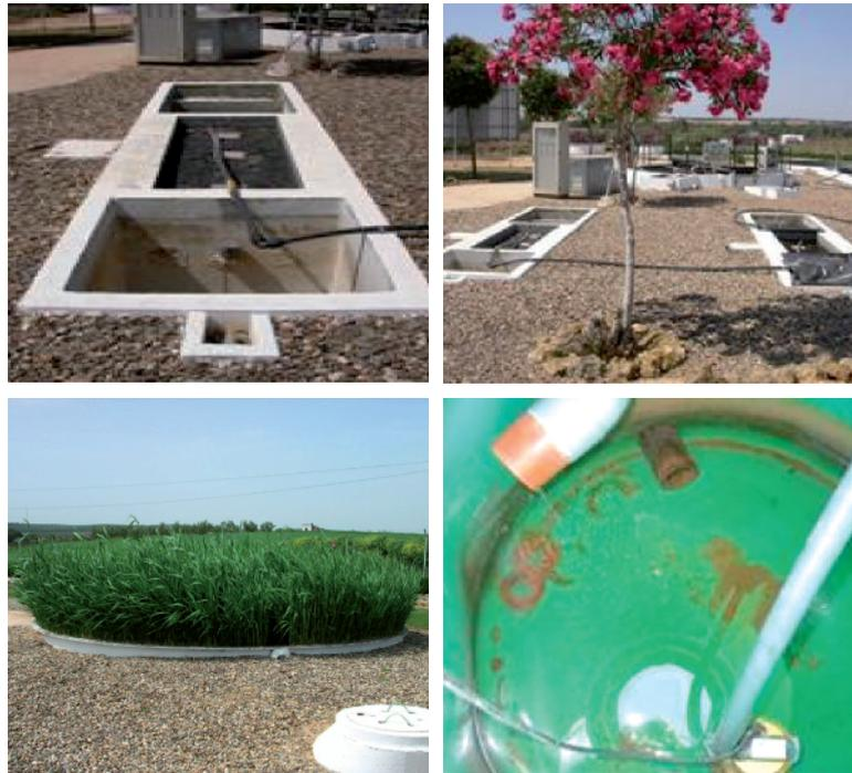
Figura 50. *Filtros de Turba*, Humedal Artificial y detalle del efluente a la salida del Humedal. Planta Experimental de Carrión de los Céspedes.
