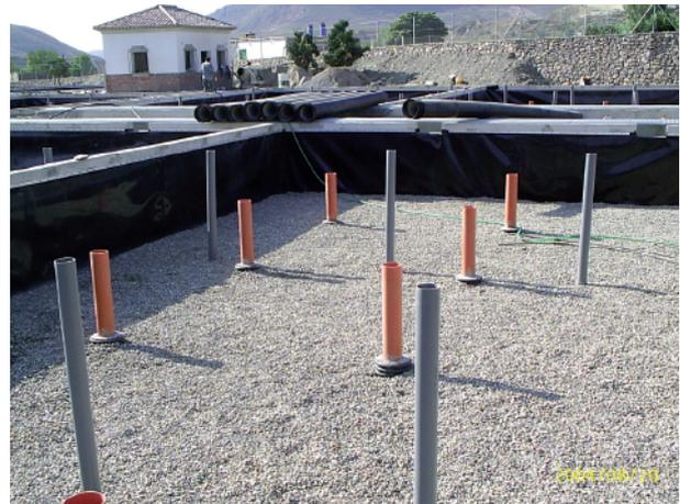
**Figura 28.-** Chimeneas de ventilación del sustrato filtrante.
