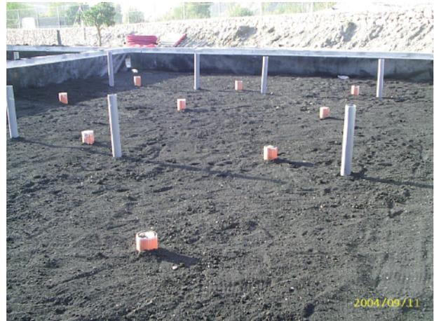
**Figura 33.- Turba ya colocada. Se aprecian las chimeneas de alimentación y los soportes (tubos cortos) para las tuberías de reparto.**
