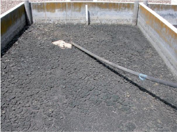
**Figura 46.- *Filtros de Turba* empleado como Era de Secado de Lodos.**
