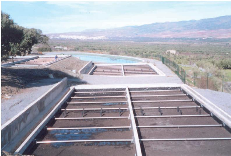
Figura 56.- Diagrama de flujo y vista de la EDAR de Abrucena (Almería). *Lagunaje Anaerobio + Filtros de Turba + Lagunaje de Maduración.*
