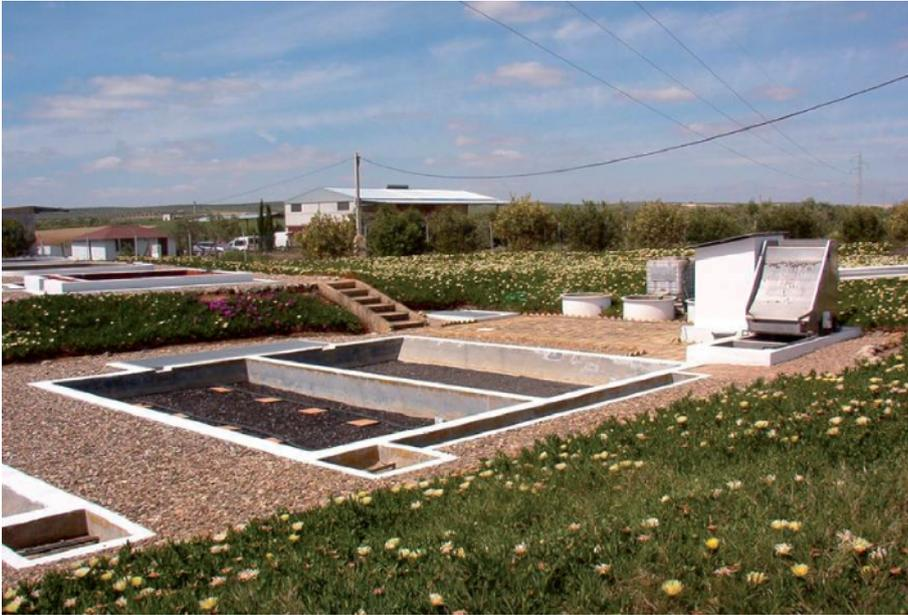
Figura 16. - Instalación de tratamiento mediante *Filtros de Turba* en la que se observa el tamiz autolimpiante, ubicado sobre un desengrasador estático, y los *Filtros de Turba*.
