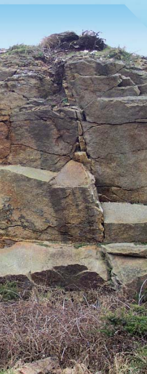
Affleurement sur le site de Ploemeur (56) montrant des granites fracturés. Sur ce site, les écoulements sont très rapides dans les fractures et très lents dans la roche non fracturée.
