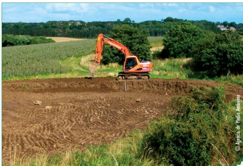
Un estanque de almacenaje no alineado en construcción en la esquina de un terreno
