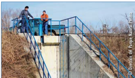
Esclusa de afluencia en el dique de protección de la isla de Persina
