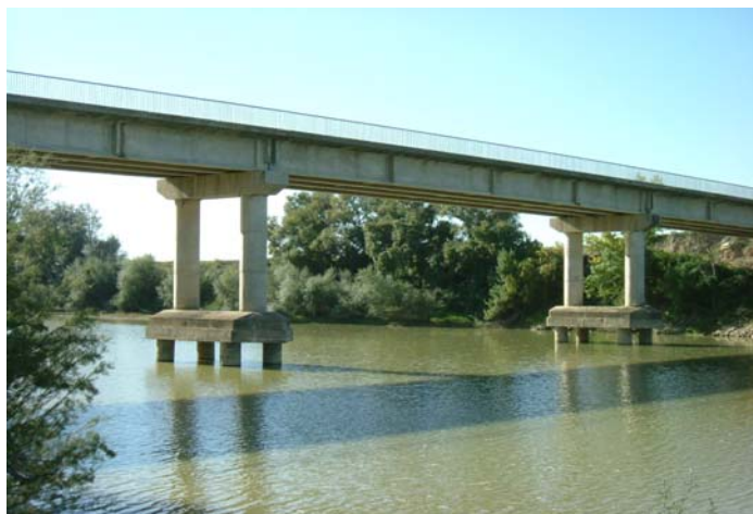
Síntomas de incisión en el puente del río Ebro en Buñuel. Foto: Fernando Magdaleno.
