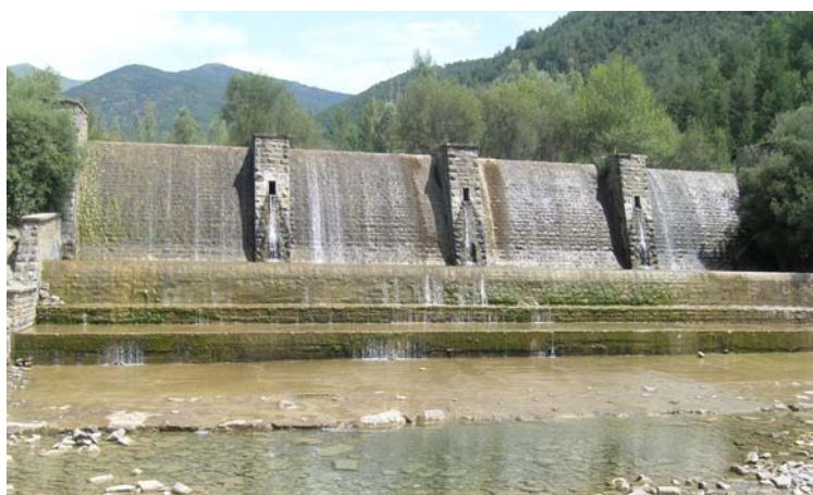
Presa de retención de sedimentos en el río Aurín, afluente del Gállego. Foto: Alfredo Ollero.
