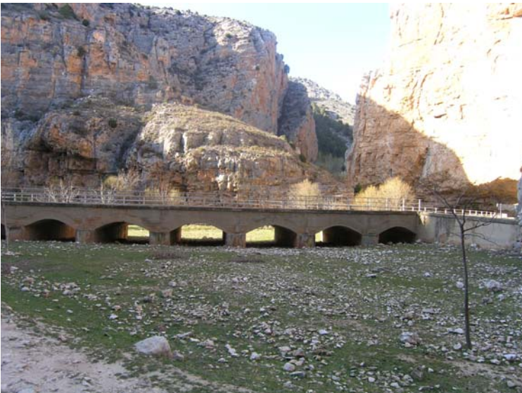
Puente con claro efecto de retención de sedimentos en la rambla de Cañada Campillo, afluente del río Mesa, en Jaraba. Foto: Alfredo Ollero.
