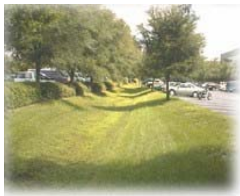
Fig.4 Canal permeable, integración de paisaje y urbanismo
