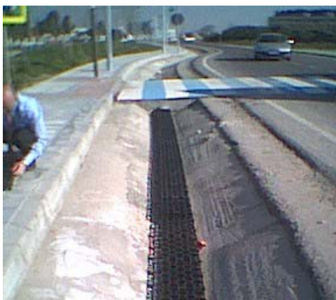
1. Extensión de celdas de drenaje
