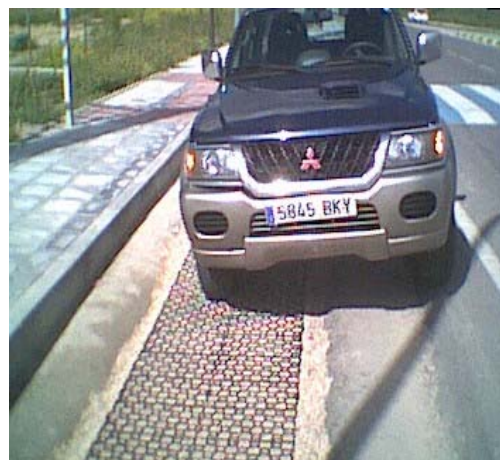
4. Gravilla estabilizada, transitable
