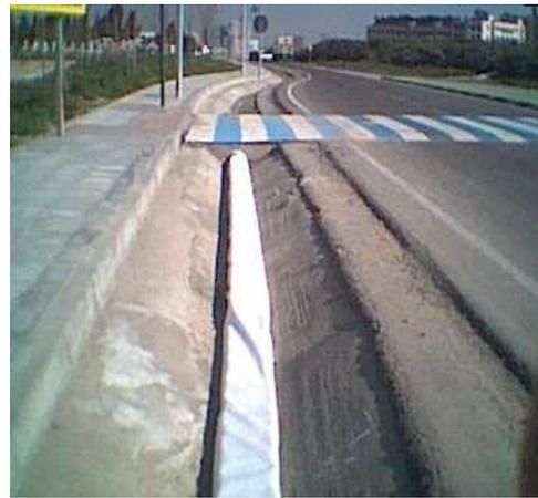
2. Envoltorio celdas con geotextil permeable
