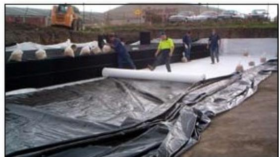
Se aconseja utilizar sacos de arena o piedras para evitar el deslizamiento de la lámina geotextil al fondo de la excavación.
