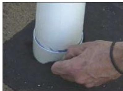
Deslizar el tubo a través del geotextil y el panel Atlantis.
