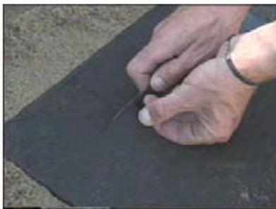
Cortar una ranura en X sensiblemente inferior al diámetro del tubo, para que el tubo quede ajustado.
