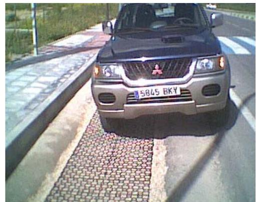
4. Gravilla estabilizada con celdas de 52 mm
