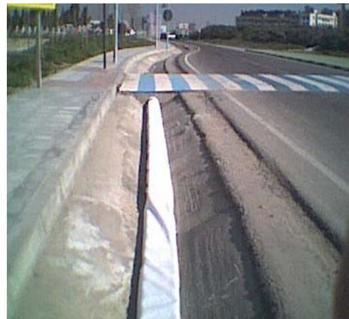
2. Envoltorio celdas con geotextil permeable
