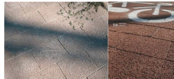
TIPO DE SISTEMA CONSTRUCTIVO DE DRENAJE URBANO: PAVIMENTO DISCONTINUO DRENANTE: ADOQUINES DRENANTES.
