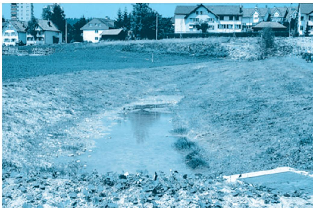
*Bassin de rétention et d'infiltration recouvert d'humus*
