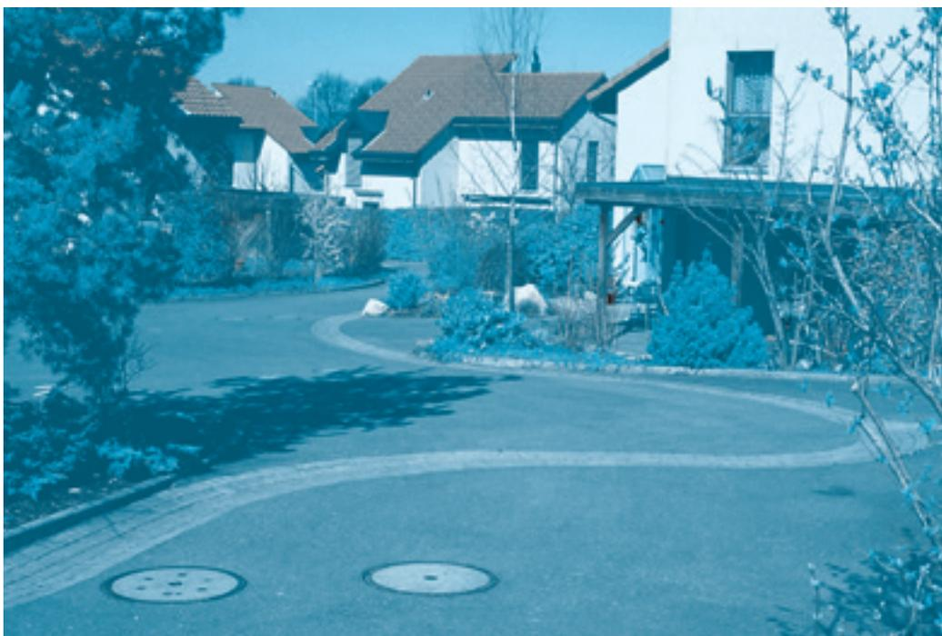
*Caniveau d'écoulement comme élément d'aménagement de la route*
