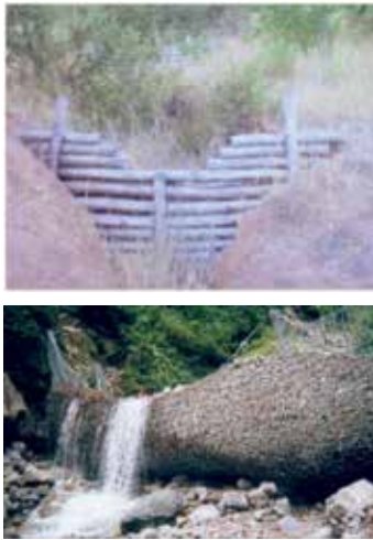
Figura 3. Pequeñas retenciones del escurrimiento: a) de postes impregnados y bolsas de tierra; b) barreras flexibles permeables, con redes de anillo. (Fuente: Geobruigg, 2012).
