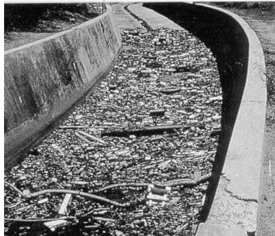
Canal de hormigón: Sistema impermeable que Magnifica la contaminación del agua
