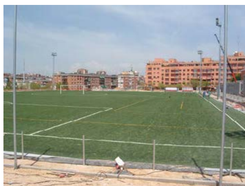
Campo de fútbol, hierba artificial dotado de sistema cerrado y reciclado de agua de lluvia y riego. Jta. Mun. Arganzuela MADRID
