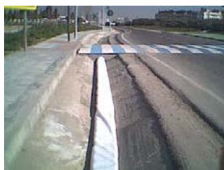
Situación original – Extensión de celdas – Envoltorio en geotextil permeable – Gravilla estabilizada transitable
