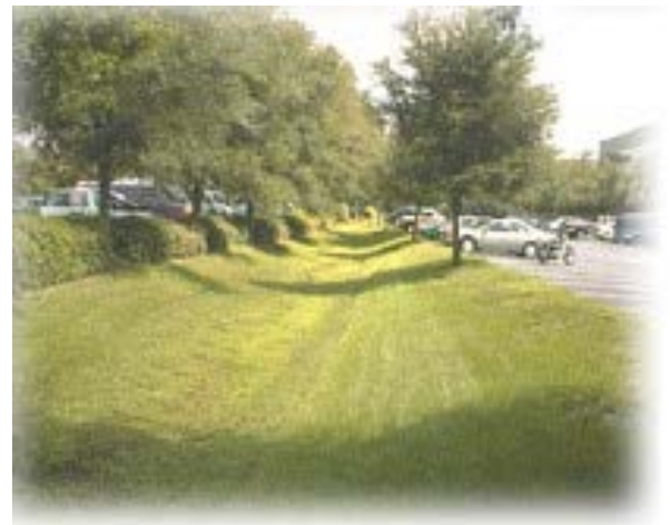
Canal permeable, integración de paisajismo y urbanismo
