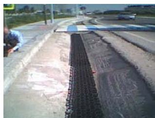
Situación original – Extensión de celdas – Envoltorio en geotextil permeable – Gravilla estabilizada transitable
