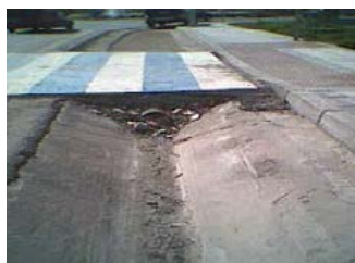
Situación original – Extensión de celdas – Envoltorio en geotextil permeable – Gravilla estabilizada transitable
