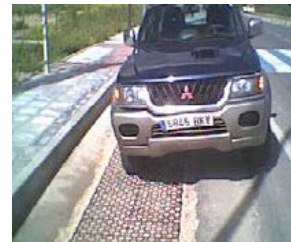
Situación original – Extensión de celdas – Envoltorio en geotextil permeable – Gravilla estabilizada transitable
