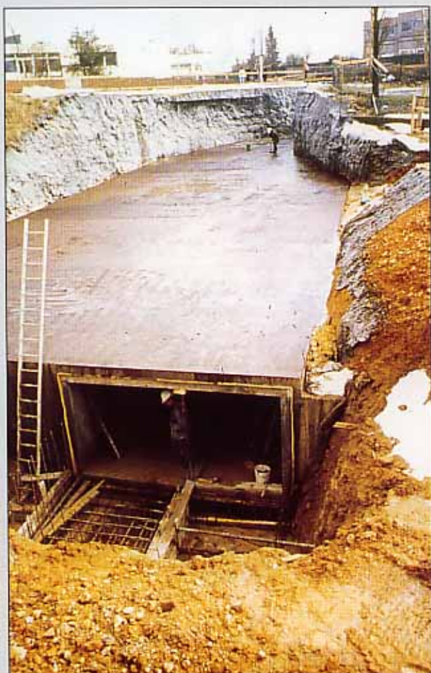
Construction du bassin enterré de la Vologne à Nancy. Capacité et stockage : 17 000 m 3
