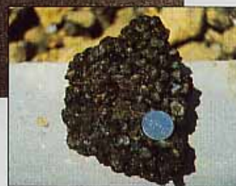
Détail du revêtement poreux.
