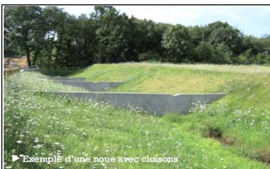
▶ Exemple d'une noue avec cloisons
