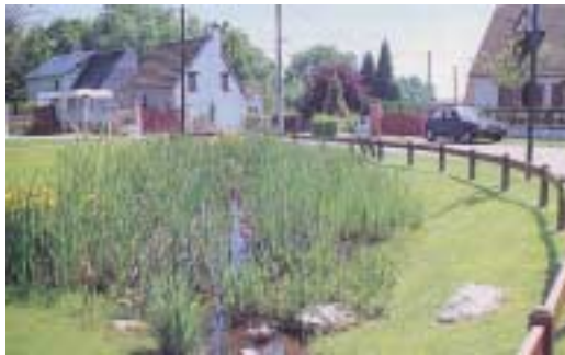
Noue engazonnée Opération Belbeuf – 76 Source Foncier Conseil
