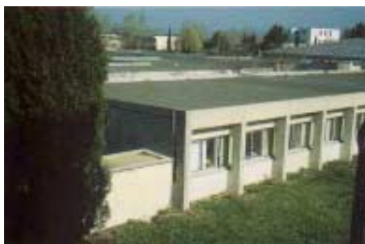
Toiture – terrasse Source CERTU
