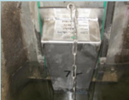
Régulateur à effet siphon avec chaîne d'extraction
