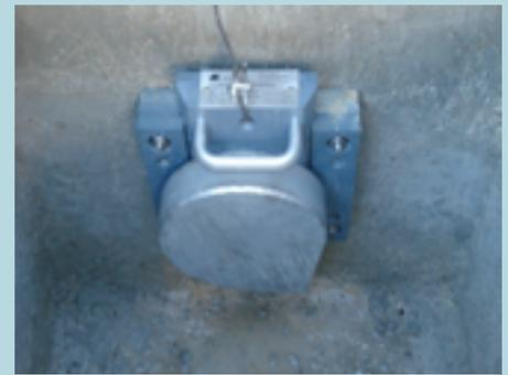
Régulateur à effet siphon avec rail de positionnement
