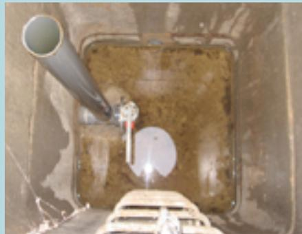
Accessibilité de la vanne de vidange et de la surverse d'un bassin
