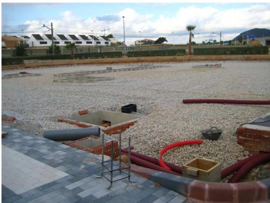
**Figura III. 8. Colocación de sub-base granular sobre geotextil.**
