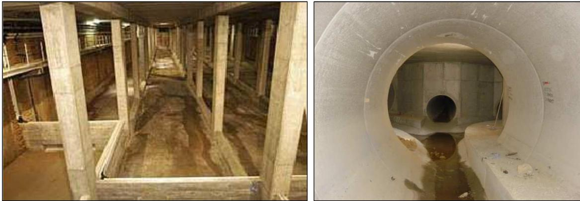
Figura I. 14. Tanque de tormentas en Barcelona (izquierda) y colector de gran diámetro (derecha).
