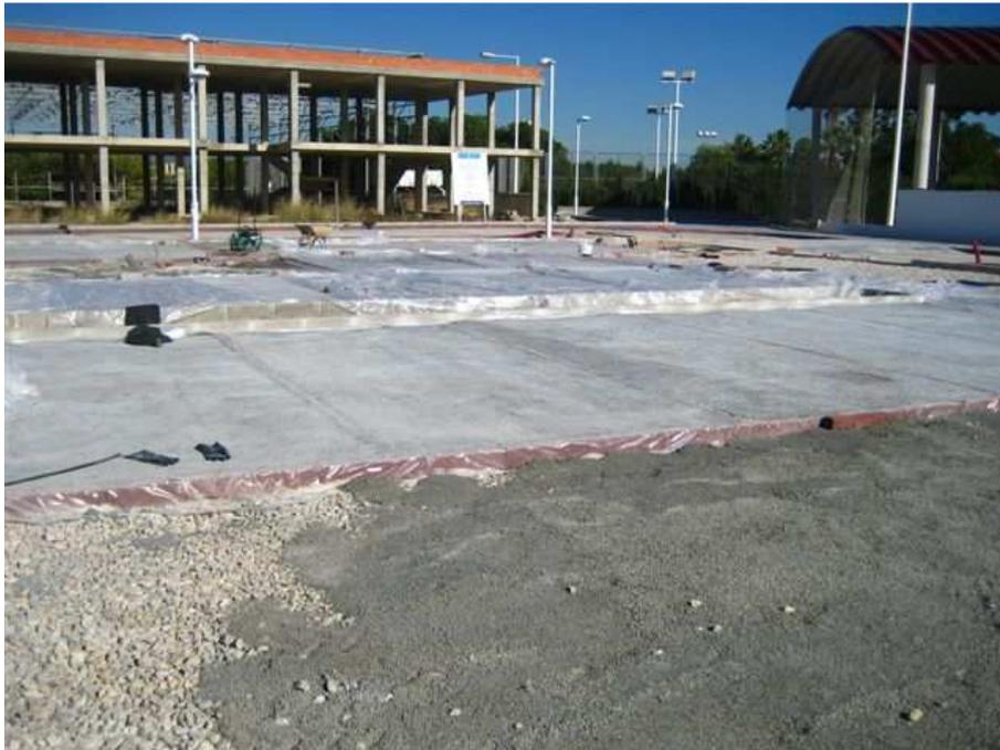
**Figura III. 9. Vertido del hormigón poroso sobre la sub-base.**
