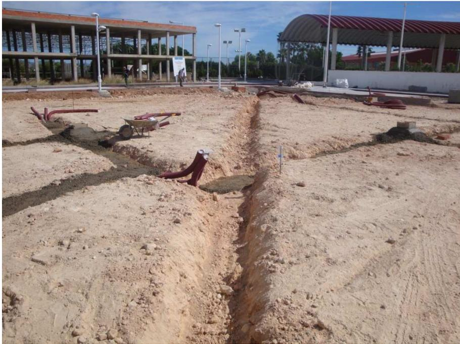
**Figura III. 5. Construcción del dren inferior.**
