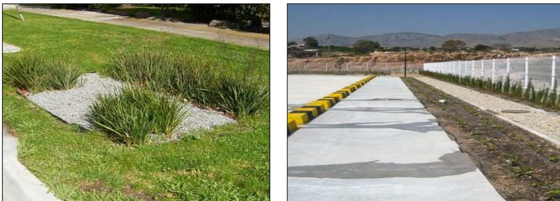
**Figura I. 19. Pozo de infiltración (izquierda), zanja de infiltración (derecha).**
