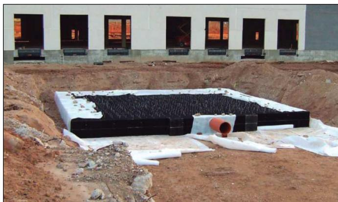
Figura I. 20. Depósito de infiltración.
