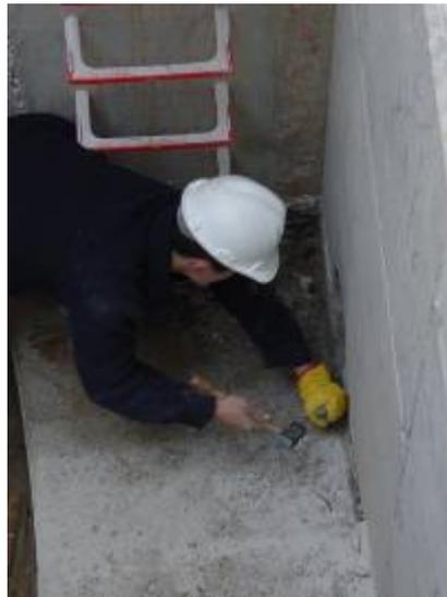
Taladrar el hormigón utilizando los orificios de las esquinas superiores como guía. Introducir los dos pernos, con ayuda de un martillo.
