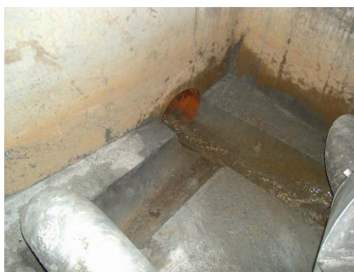
Figura 8: Conducto de salida y medias cañas a la salida del vortex y del by-pass
