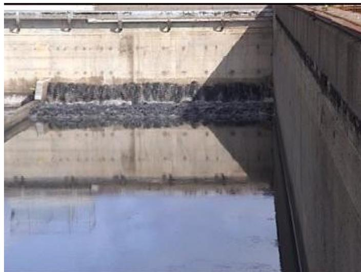
Ola de limpieza generada por la descarga del sistema de vacío.
