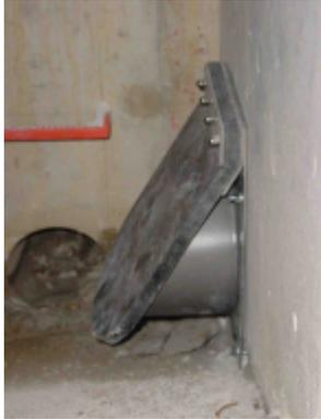
Detalle Clapeta Instalada
