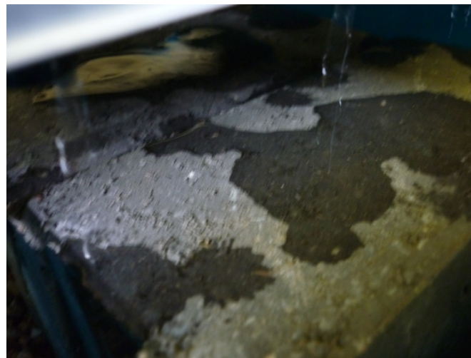
Figura 48. Adoquines impermeables de hormigón en disposición permeable utilizados como capa de superficie permeable.
